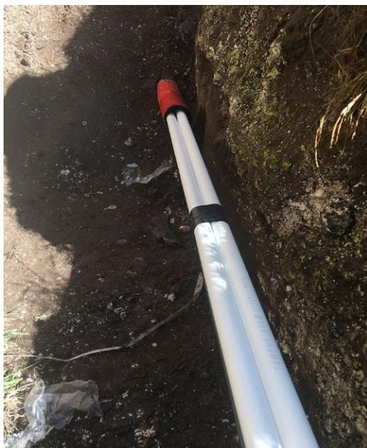
Først trak entrepenøren det store, røde yderrør i en dybde på 1,1-1,5 meter under overfladen.
